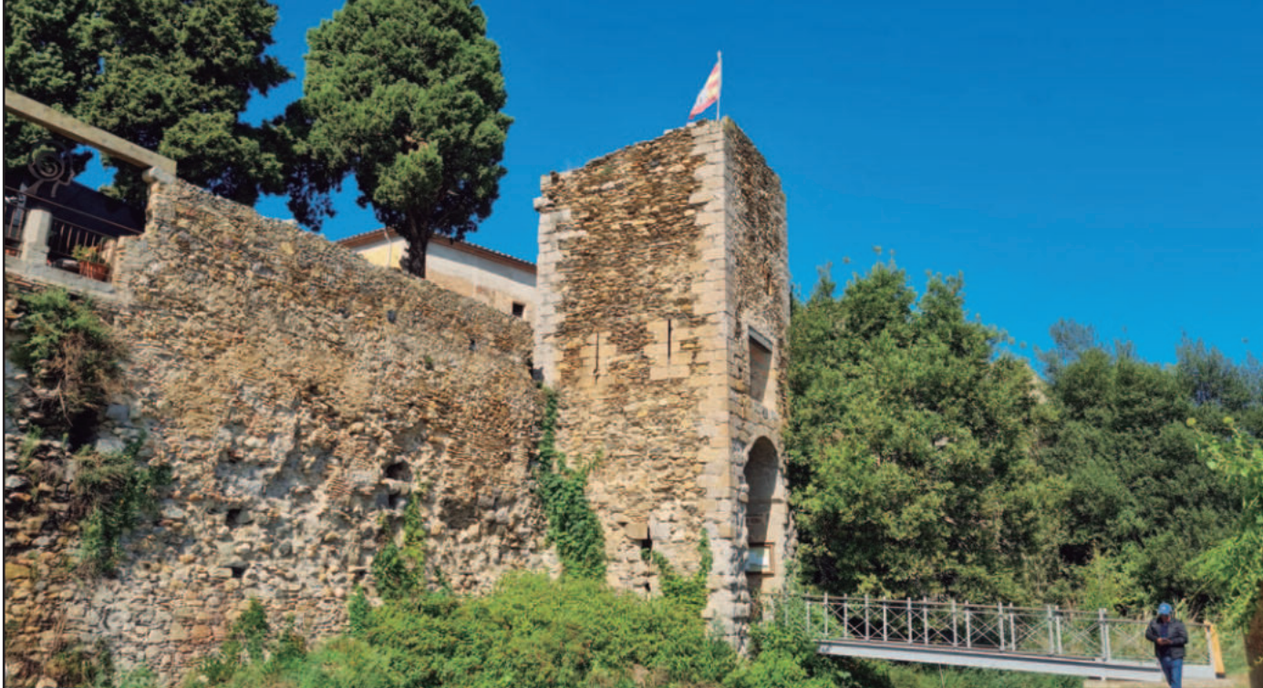
Muralla i Portal de la Gallarda
