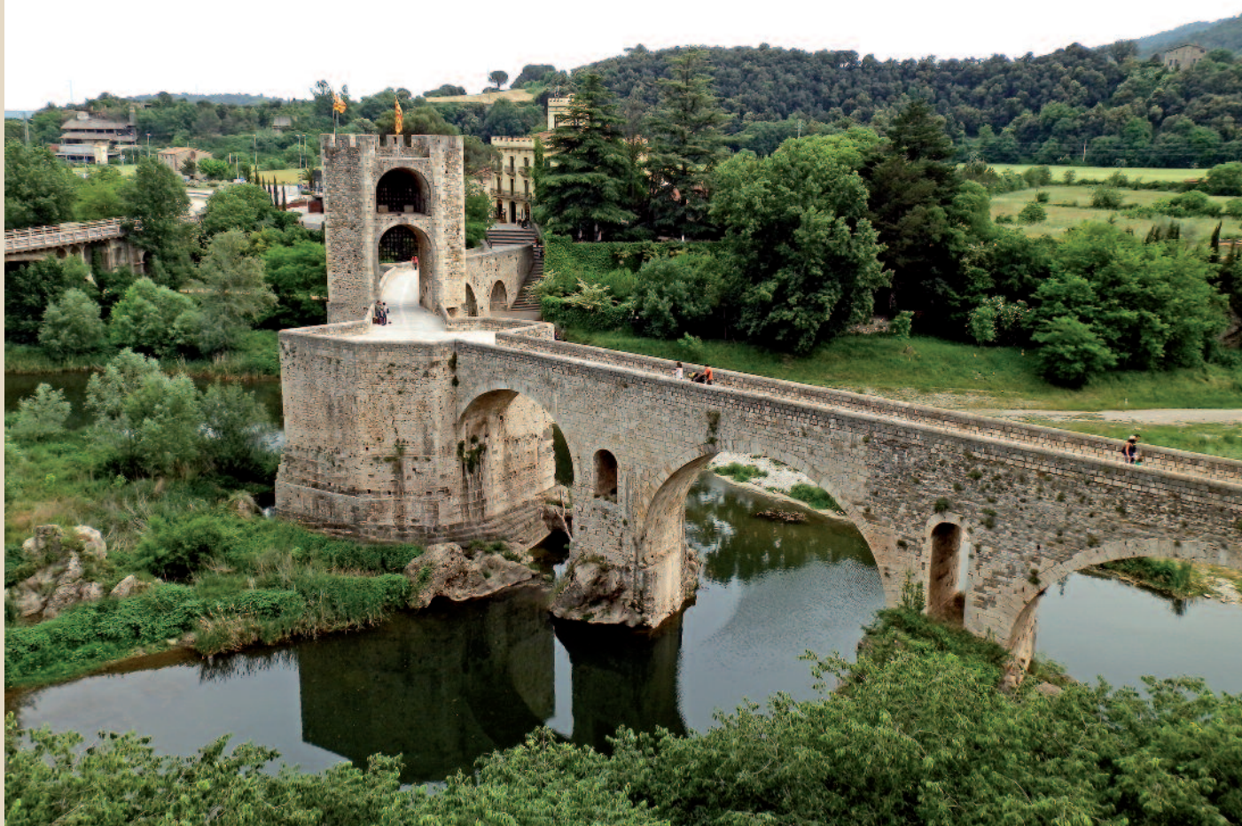
Panoràmica del pont de dalt de les muralles
