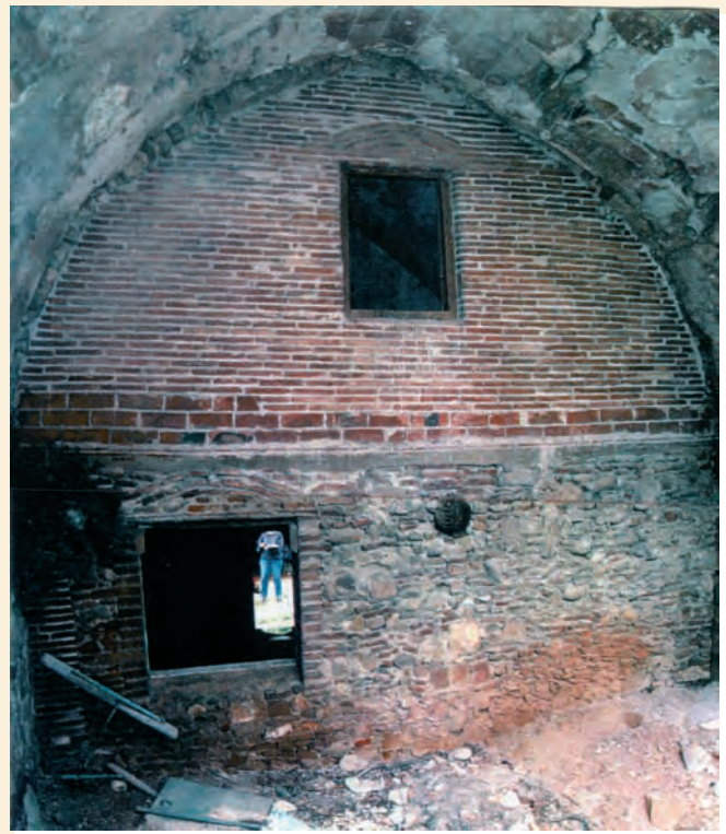
És un parament vertical que divideix l'estança de la capella en dues parts. La part anterior s'utilitza actualment com a magatzem. La part posterior és l'original i la trobem plena de runa.
