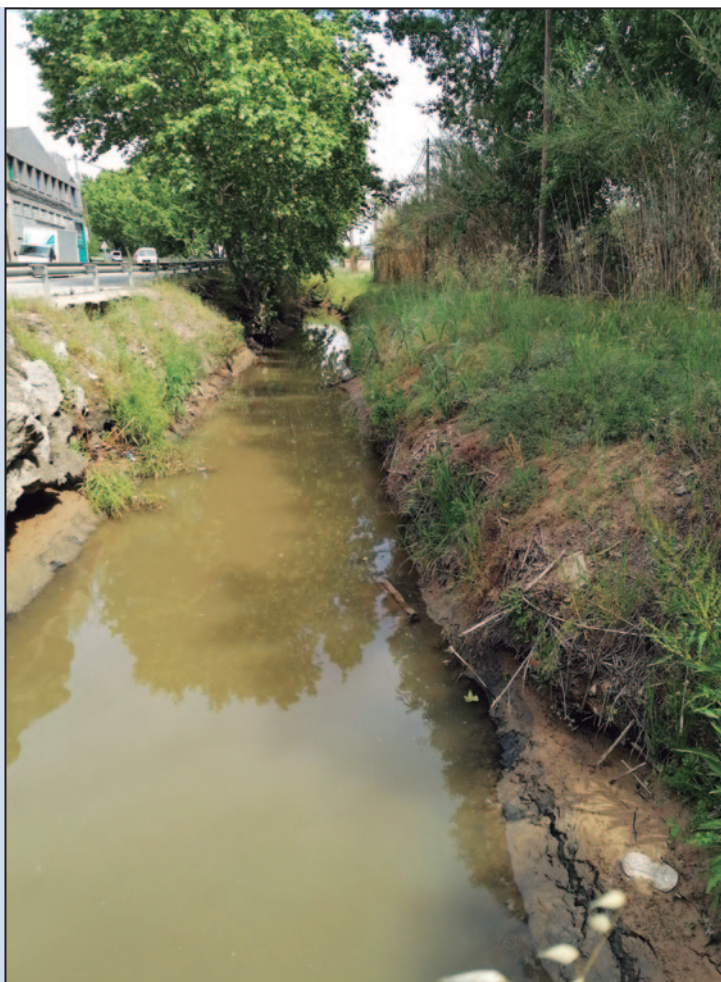
Canal de la Dreta
