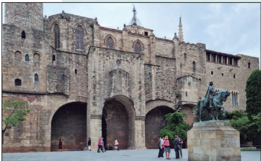
Monument a Ramon Berenguer III i llenç de muralla al fons. Exemple de mètodes de restauració
