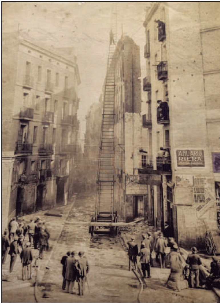
Incendi de la fàbrica de torçats i filats La Manresana, al carrer de la Cera. 1899. Autoria: Antoni Esplugas. AFB
