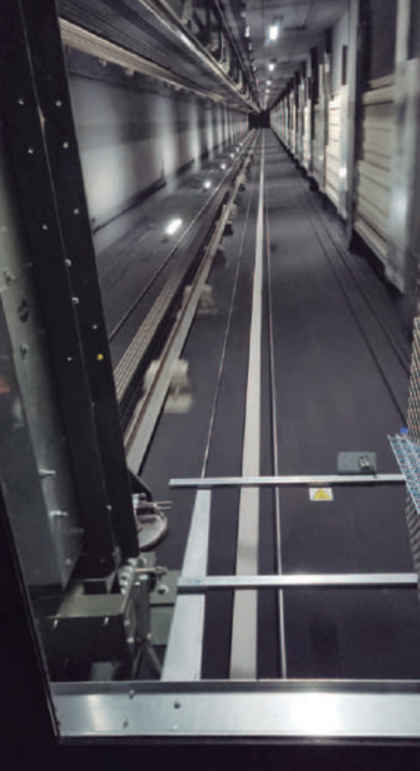
Sostre de l'ascensor de pujada al Mirador
