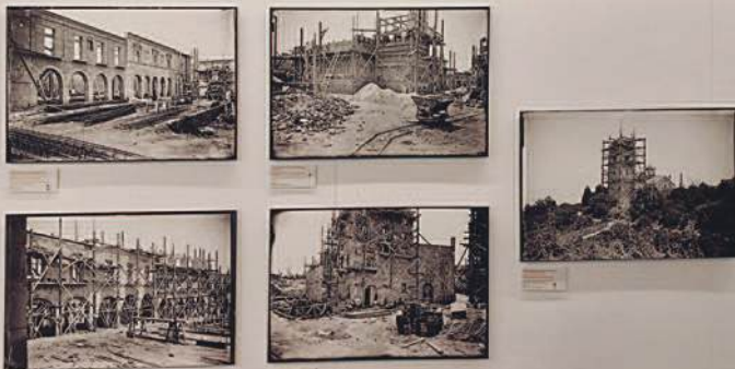
Fotografies de la construcció de la Plaça Major
