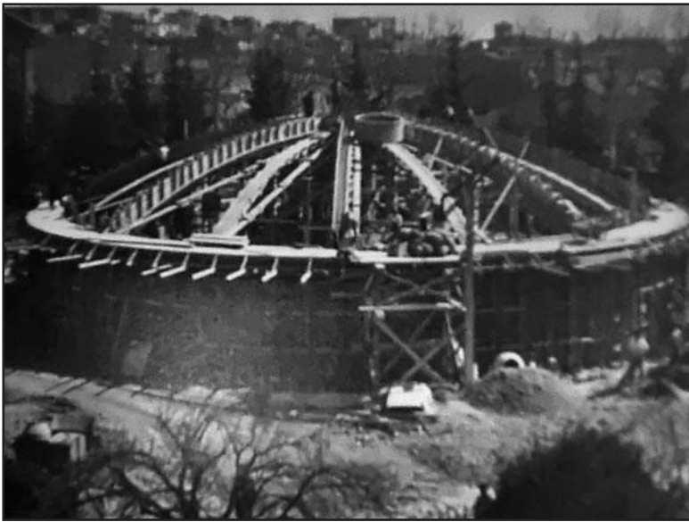
Fotografia de la construcció del Dipòsit Circular l'any 1954. Arxiu SGAB
